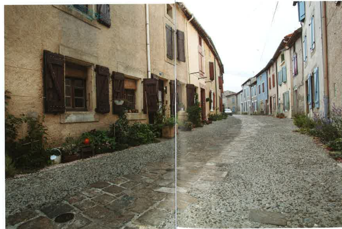
Pierres et béton ont été acheminés par dumper dans les ruelles.
