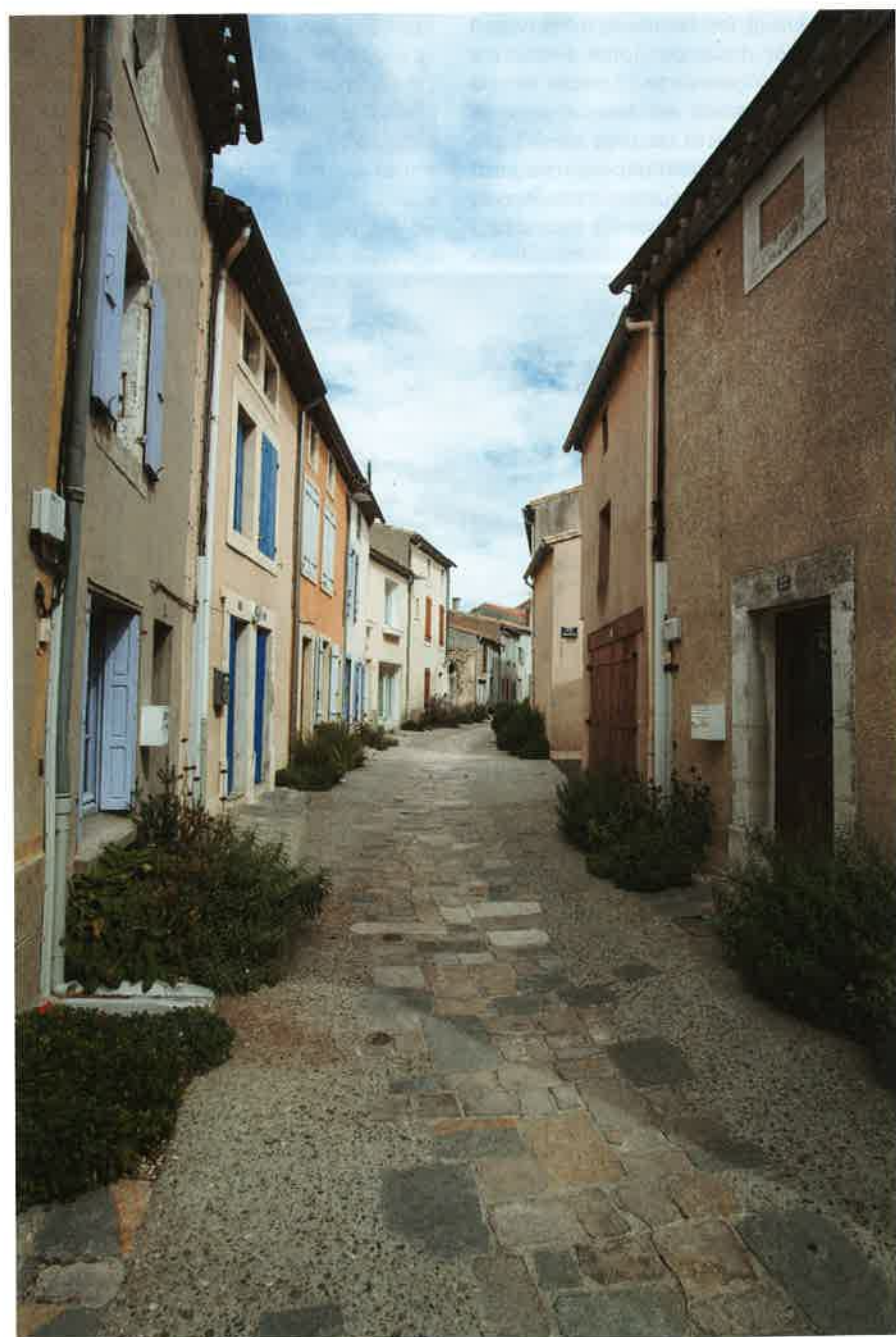
Le corps de chaussée a été réalisé en béton désactivé, formulé à partir de granulats de Bram et incrusté de pierre de Montdardier.
