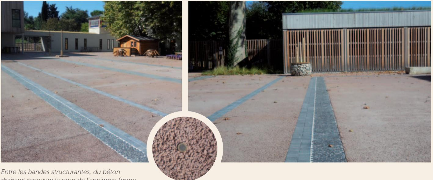
Entre les bandes structurantes, du béton drainant recouvre la cour de l'ancienne ferme.
