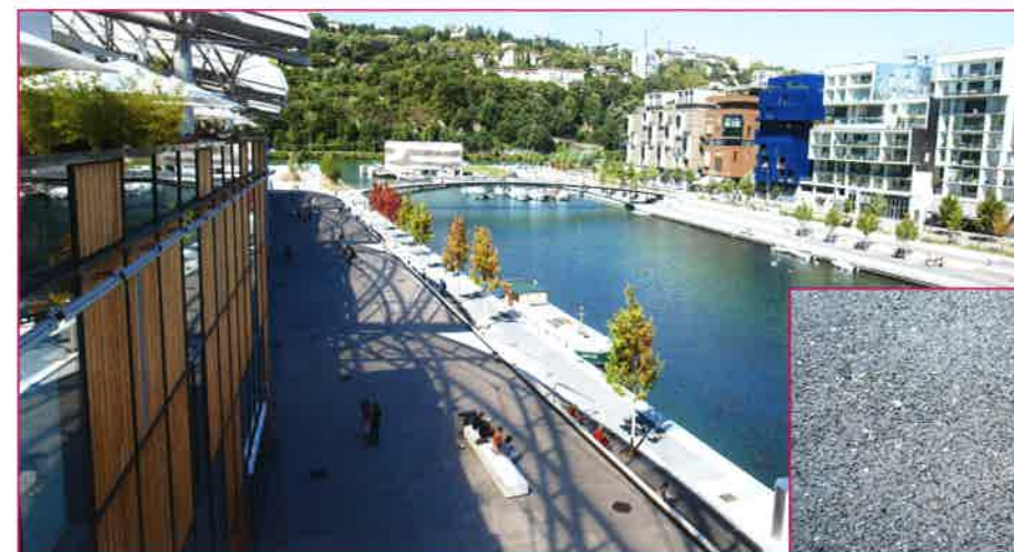
Lyon Confluence : le calepinage dessine des rectangles réguliers, ce qui minimise les traits de scie pour les joints. Les particules scintillantes sont incorporées au béton par un talochage soigné.
