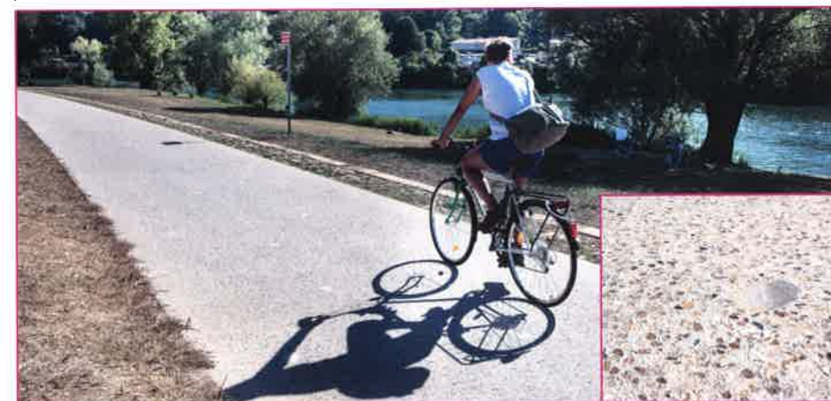
Rives de Saône : sur la promenade des guinguettes à Rochetaillée-sur-Saône, la surface bouchardée facilite la circulation des cyclistes, surtout les jours de pluie.
