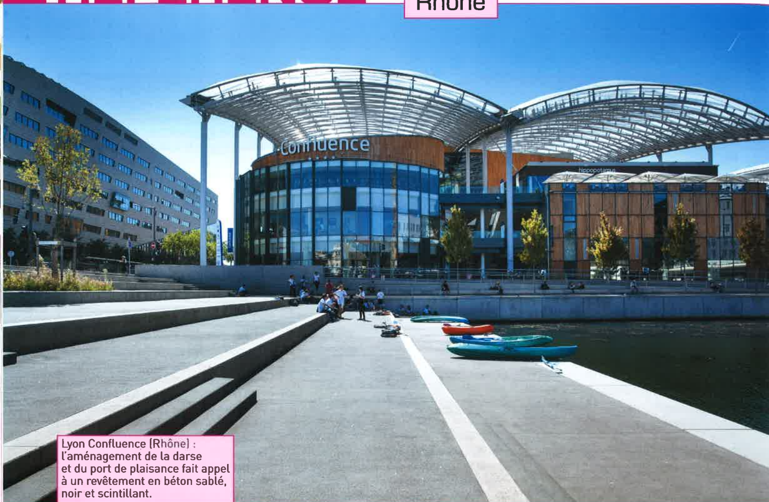
Lyon Confluence : le calepinage dessine des rectangles réguliers, ce qui minimise les traits de scie pour les joints. Les particules scintillantes sont incorporées au béton par un talochage soigné.
