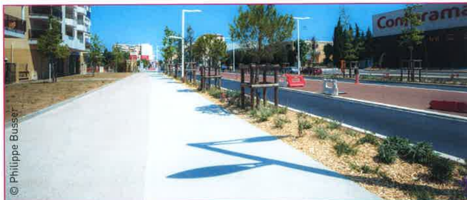
Cannes : les traitements de surface ont permis de distinguer visuellement les usages de circulation : béton désactivé pour les piétons (à gauche) et béton sablé pour les cyclistes (à droite).
