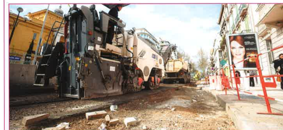
Cannes : le rabotage de l'enrobé orniéré a été réalisé sur 10 cm d'épaisseur, avant le coulage d'une épaisseur identique de BCMC sur une structure grave bitume de 13 cm.
