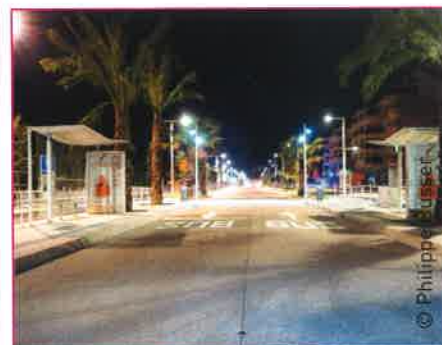
Cannes : la nuit, le revêtement en Béton de Ciment Mince Collé (BCMC), grâce aux granulats clairs, assure une excellente réflexion de la lumière émise par l'éclairage urbain.
