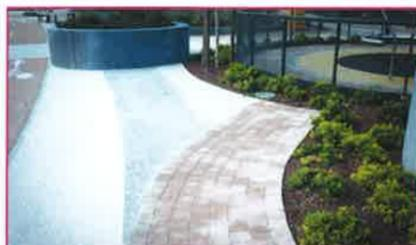
Béton bouchardé, béton désactivé, pavés béton, jardinières en béton préfabriqué : le matériau béton crée un espace invitant à déambuler devant les boutiques.
