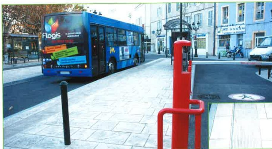
Montélimar : sur les arrêts de bus a été utilisé un béton imprimé, avec motif de dalles de couleur beige clair, intégrant en surface du béton des stries pour indiquer aux personnes déficientes visuelles l'endroit où attendre le bus.
