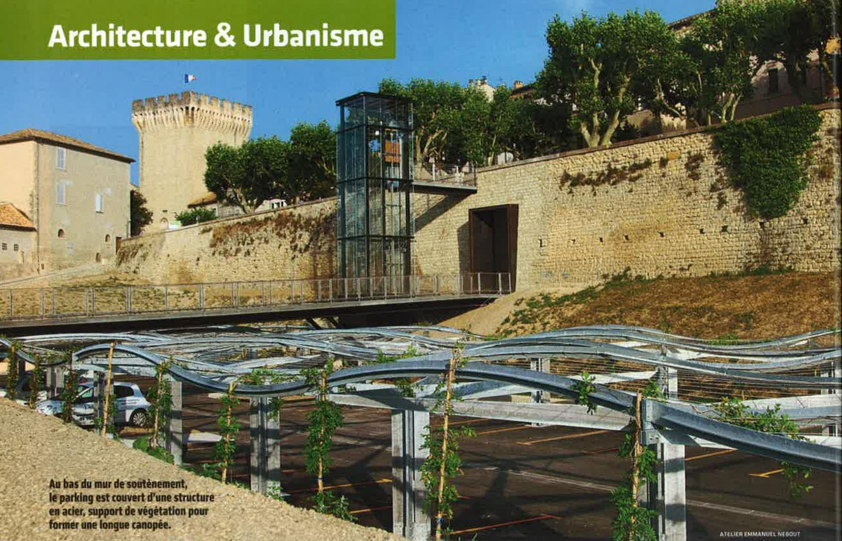
Au bas du mur de soutènement, le parking est couvert d'une structure en acier, support de végétation pour former une longue canopée.
