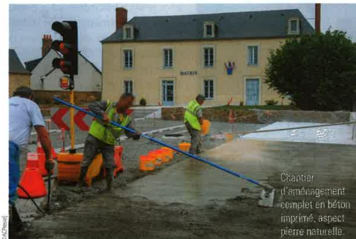
Chantier d'aménagement complet en béton imprimé, aspect pierre naturelle.
