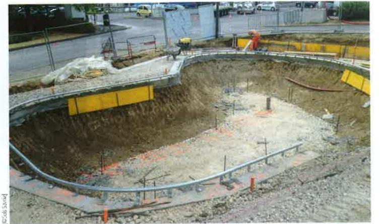
Le coping, tube métallique de 63 mm de diamètre cerclant le bowl, a été scellé.
